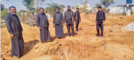
రంగాపూర్లో నిర్మిస్తున్న ఆయ్యప్పల సన్నిధాన నిర్మాణ పనులను పరిశీలిస్తున్న ఆయ్యప్ప స్వాములు
